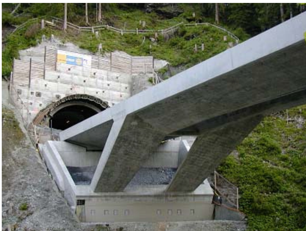
Tunnelportal "Prau Pulté" mit Flembücke
